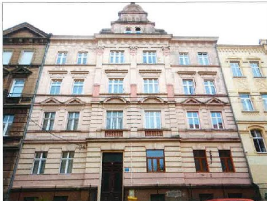
Ogólny widok budynku – elewacja frontowa.
